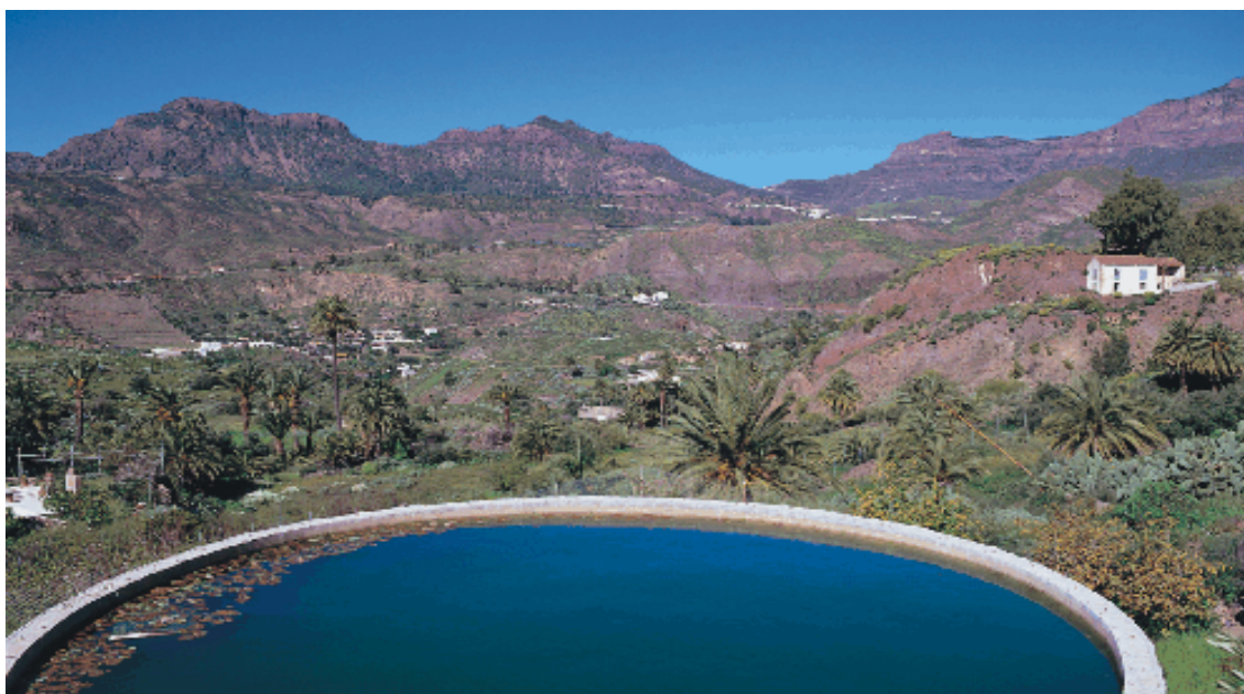
Estanque y vista hacia el barranco. A la derecha la emblemática casa de El Roquete (Foto Estudio Oliviero Daidola)
