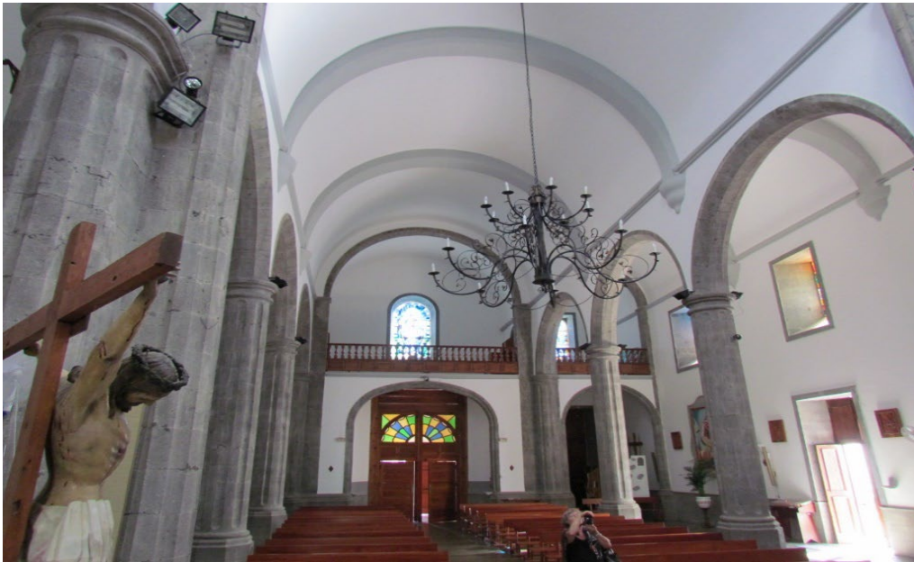
Interior de la iglesia. Vista general donde destaca el coro y la puerta principal (MRL)
