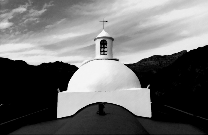
Iglesia de Santa Lucía: cúpula y linterna
