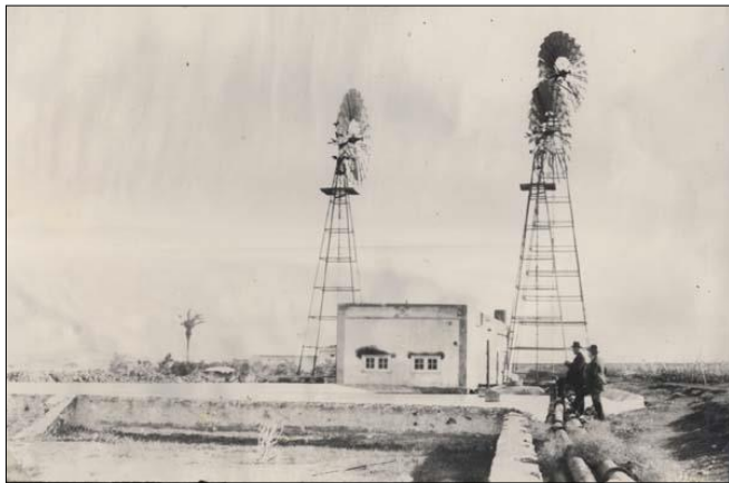
Pozo y estanque (FEDAC)
