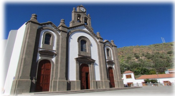
Fachada de la iglesia de Santa Lucía de Tirajana
