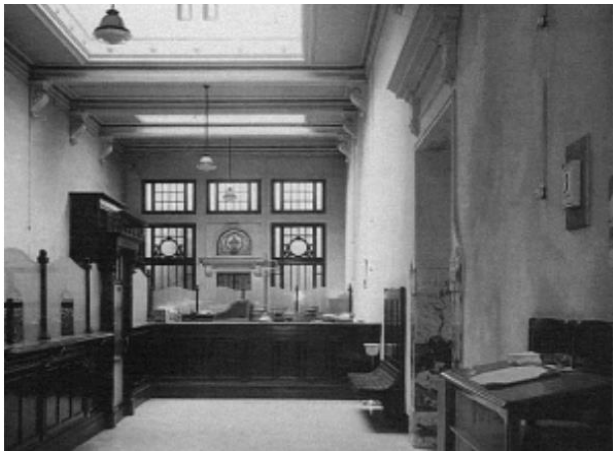
Patio de operaciones del Banco de Reus
